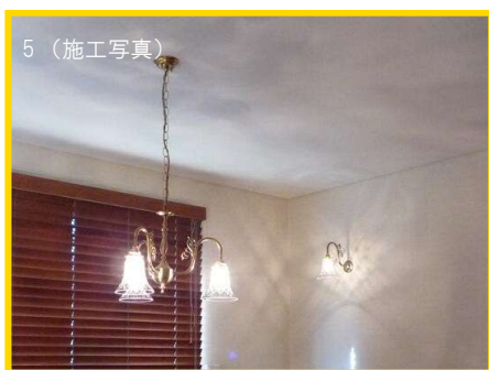
5 (施工写真) PB441/3+421/CUT H360 x W550 真鍮製/つや消し E17/60W x 3
